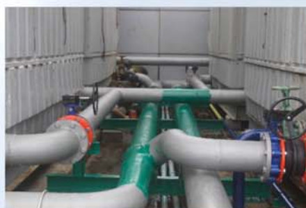
งานปรับปรุงท่อน้ำ Cooling Tower
