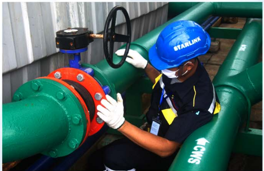
งานติดตั้ง Cooling Tower
